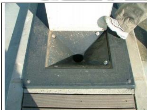
Processo de abertura simples e higiénico da tampa da pia (o que não é o caso) são fundamentais na funcionalidade da solução
